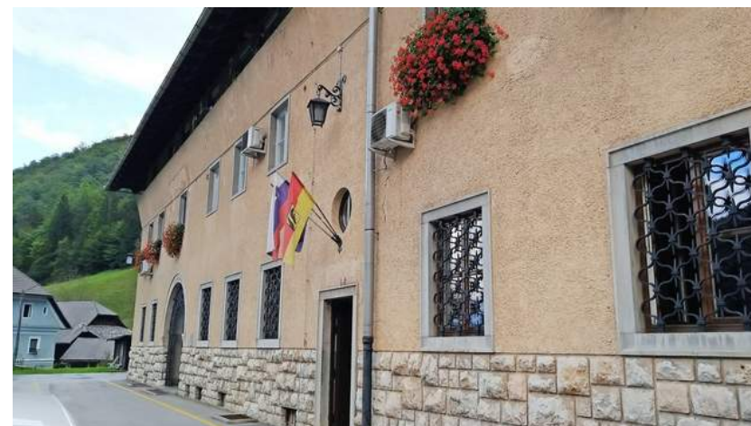
Obnova kulturnega doma v Kropi
